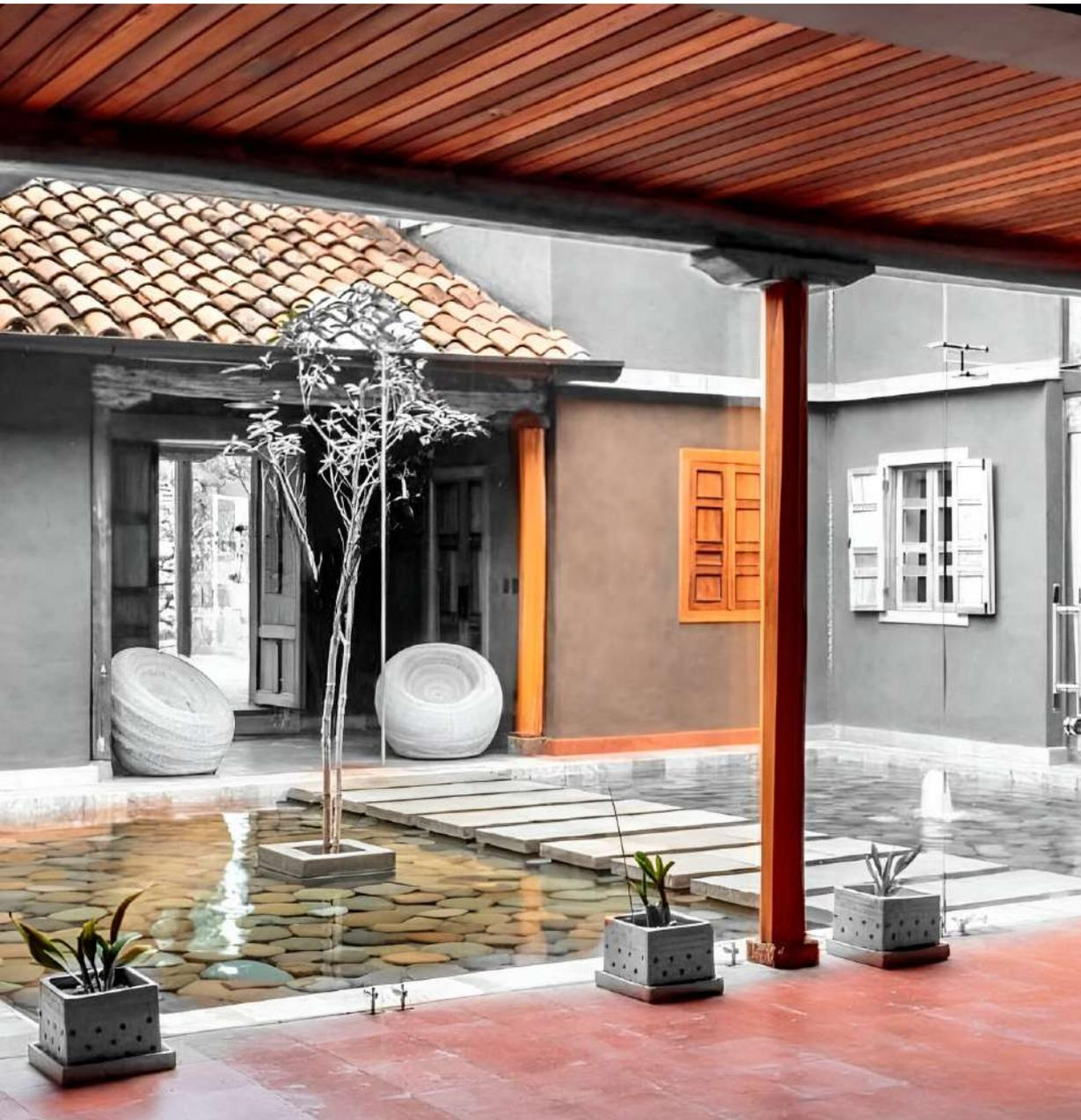
En el interior de la vivienda los materiales que se manejan tienen la intención de no contrarrestar con los de sus áreas exteriores. Por lo tanto se utiliza teja, carrizo, madera de eucalipto para cubiertas, columnas y pisos de la planta nivel +2.68 metros.
