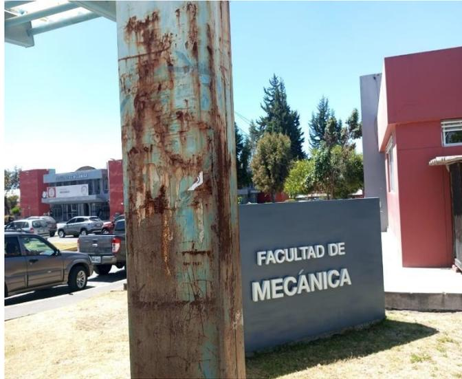
**Tipo de Corrosión:** Corrosión general (Uniforme).**Apariencia:** Desprendimiento del recubrimiento, la apariencia es de color rojizo como se muestra en la imagen por la corrosión generalizada.**Tiempo de servicio:**
