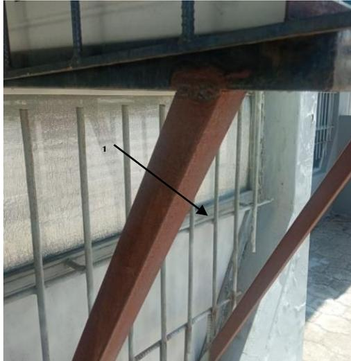
**Tipo de corrosión:** Corrosión soldadura.**Apariencia:** Corrosión perceptible a simple vista. La reja de varilla electro-soldada presenta corrosión uniforme en la totalidad de su superficie.**Tiempo de servicio:**
