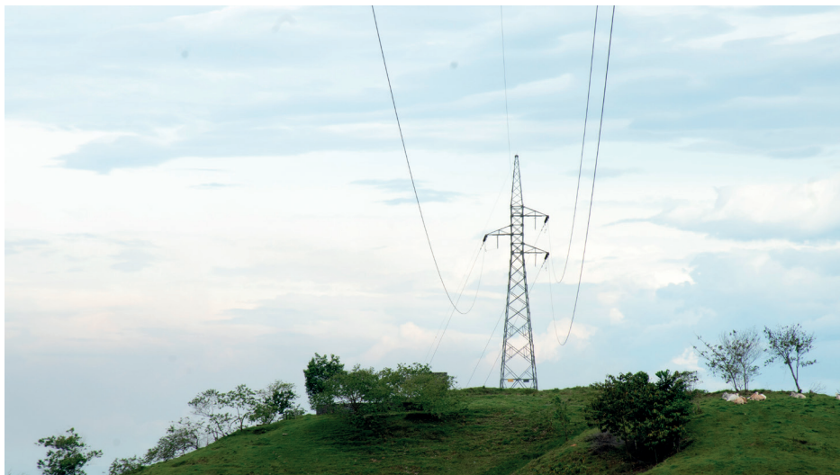
Imagen 30. Torres eléctricas, San Luis (2019). Fuente: Arbey Gómez, archivo personal.
