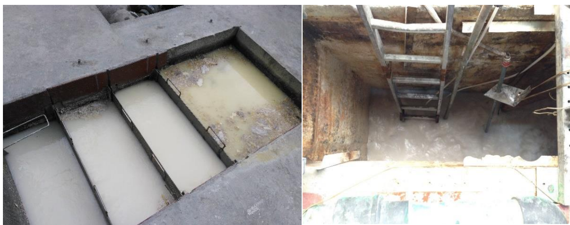
Figura 1. A. Punto de entrada de agua ruda y sistema de tamizaje; B. Tanque homogeneizar.
