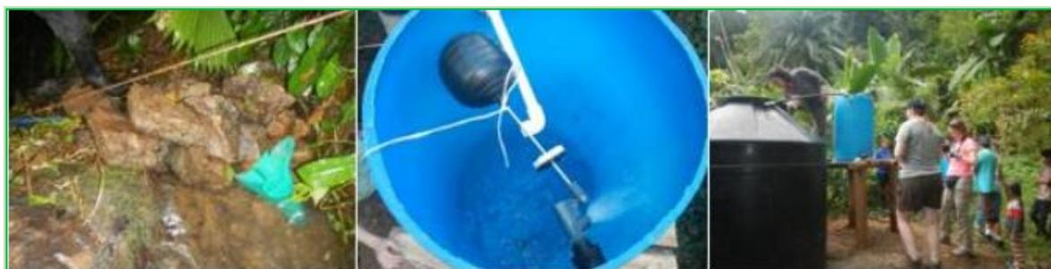
Figura 1. Sistemas de captación y almacenamiento de agua compuesta por 1) toma de agua en riachuelo (izquierda), 2) sedimentador (centro) y 3) tanque de almacenamiento (derecha).
